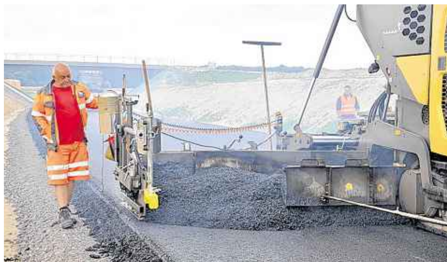
Die oberste Schicht wird auf die Umgehungsstraße Störmthal aufgebracht. Ob es beim Übergabetermin Ende 2014 bleibt, war gestern nicht zu erfahren.
